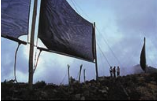
مجمّعات مياه الضباب — مشروع تجريبي رائد للصندوق لتوفير مياه شرب نقية لسكان المناطق الريفية
